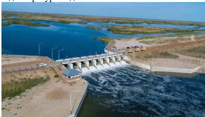
Рис.5. Общий вид гидросооружения.
